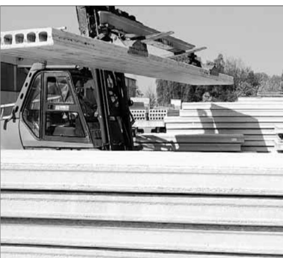
Gut eingedeckt: Verladearbeiten im Ketonia-Spannbeton-Fertigteilwerk in Almesbach bei Weiden. Die Segmente werden für den Kunden „maßgeschneidert“ gegossen und zur gewünschten Zeit auf die Baustelle geliefert. Bild: Hartl
